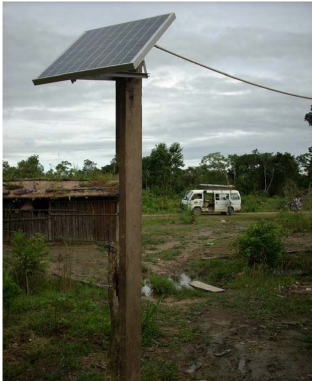
Fotografía 12. Instalación SFV en un poste de madera en el Sindicato Nueva América, (Mun. de Villa Tunari).
